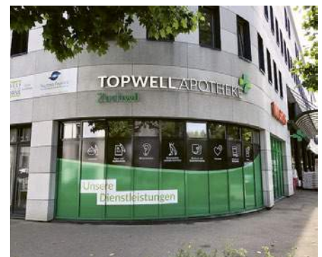
Topwell Apotheke Zuchwil nach Umbau.
